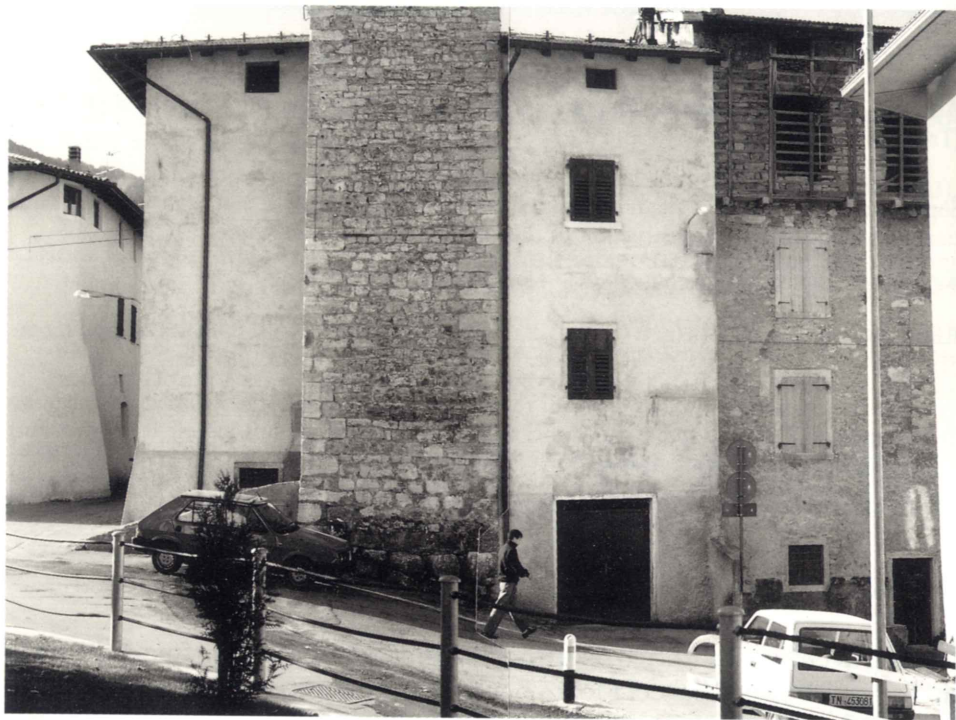
Fig. 1 - Foto d'insieme della facciata nord del complesso attuale: al centro il campanile romanico (metà del sec. XIV), sulla destra casa Segata nella quale si possono scorgere i segni di una costruzione più antica, sotto il livello del ballatoio ottocentesco. Tra i due edifici si trova la sagrestia della ex chiesetta di S. Valentino.
