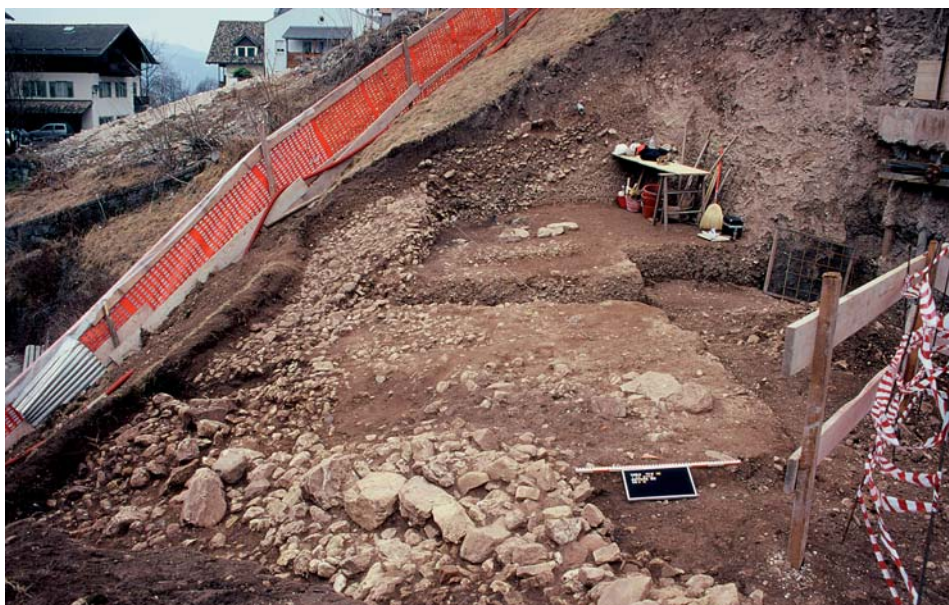
Fig. 5 - Tires, Loc. Bäckengewiesl. Particolare dello sbancamento in corrispondenza delle sezioni nord e ovest.
