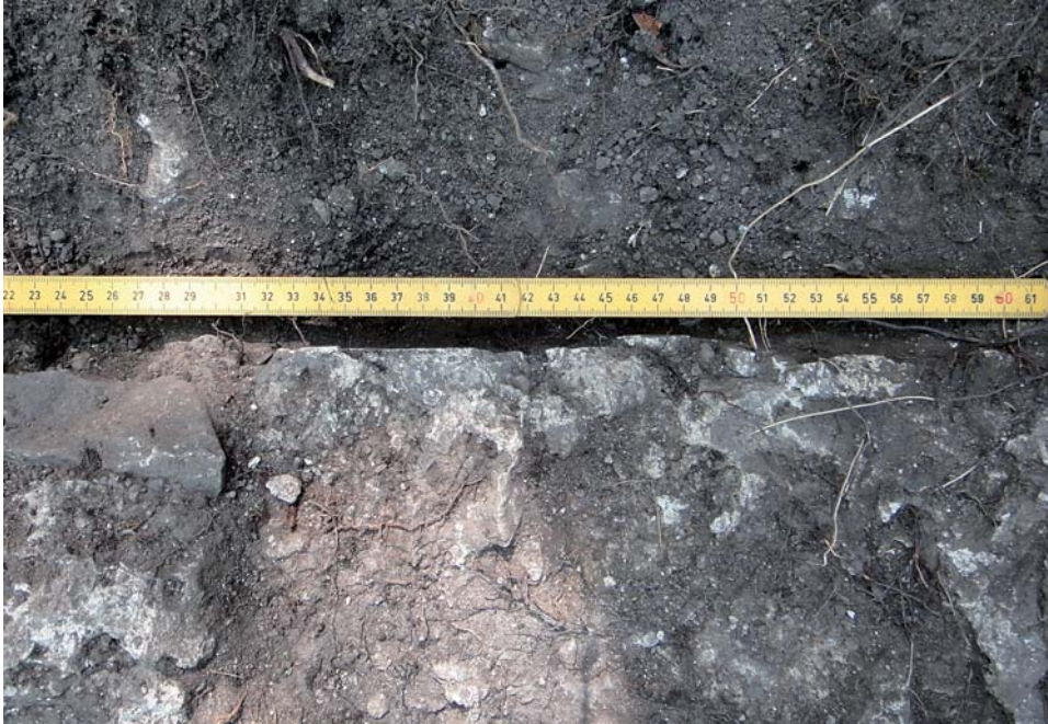
Fig. 19 - Particolare della faccia interna (sud) del muro perimetrale nord, con intonaco.
