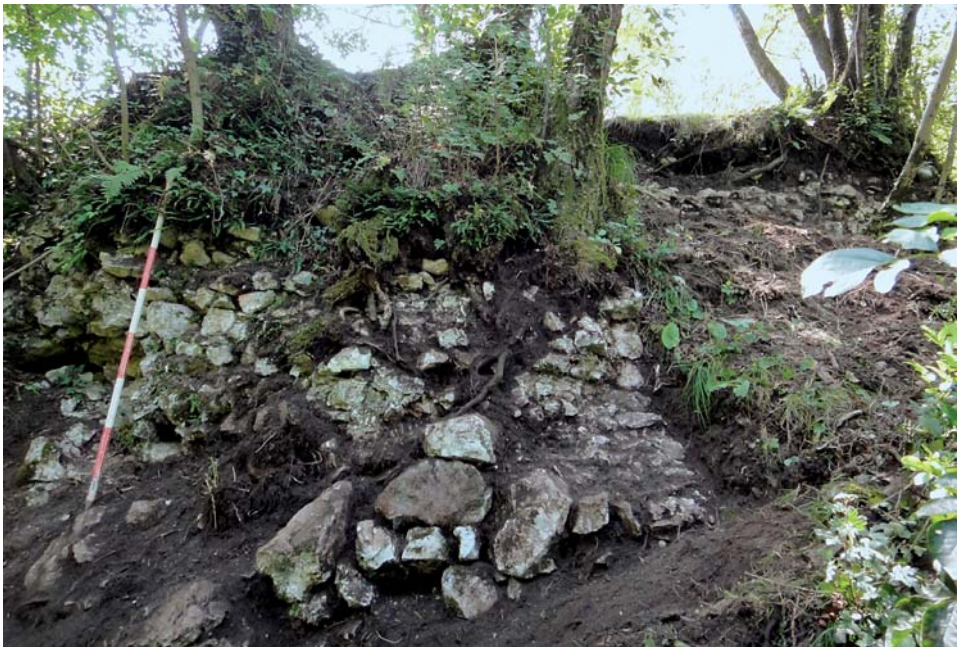
Fig. 15 - Ripresa frontale dei resti del contrafforte nord.
