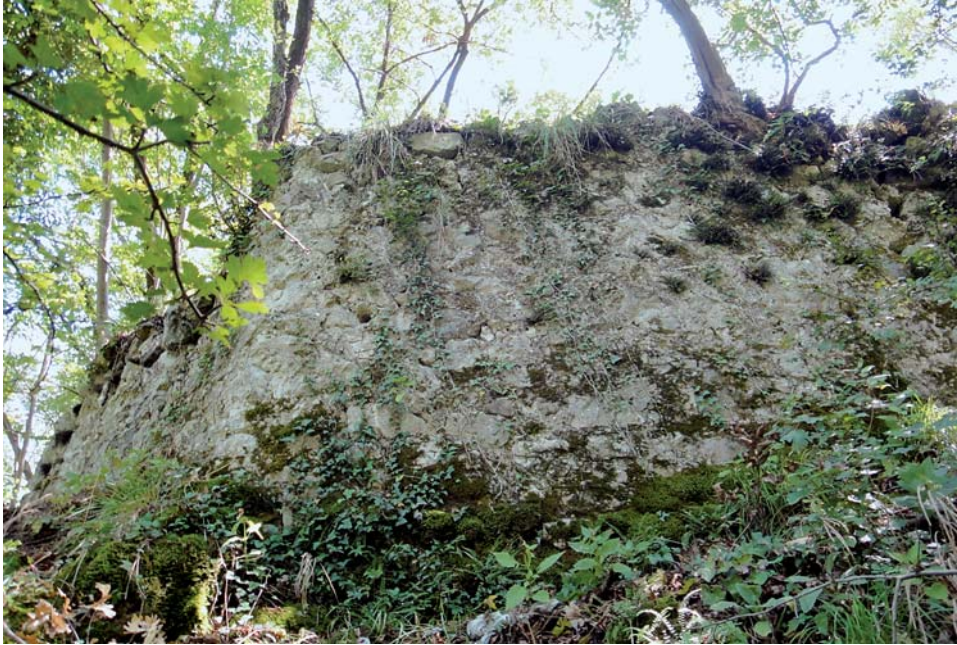
Fig. 12 - L'angolo formato dai muri perimetrali ovest e nordovest.
