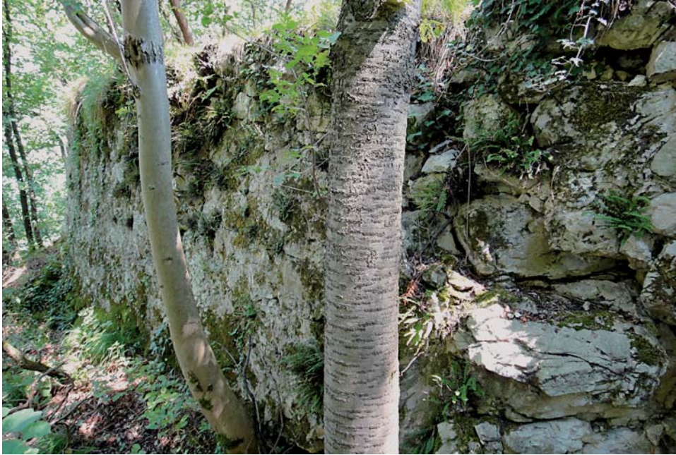
Fig. 10 - Tratto murario perimetrale lungo il fianco ovest dell'area terrazzata settentrionale.
