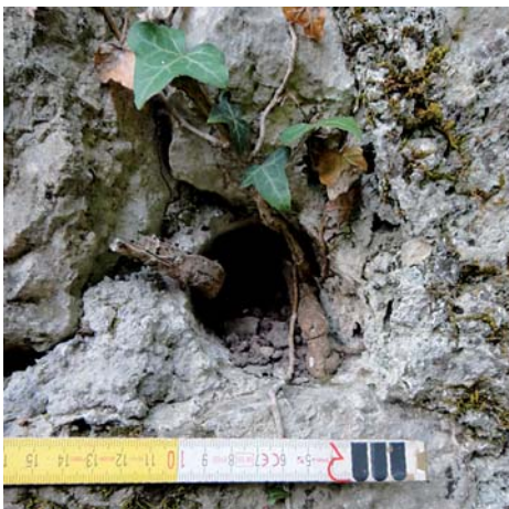
Fig. 17a-d - Fori a sezione circolare presenti lungo il lato nord-nordovest del muro perimetrale.
