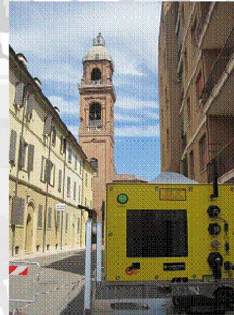
L'integrazione tra i risultati ottenuti dalle analisi TLS e le informazioni fotografiche e visive rilevate sul campo ha mostrato chiaramente effetti riconducibili ad una torsione dovuta alle numerose scosse di terremoto. In particolare la parte compresa tra quota 20 m e quota 32 m (circa) è evidentemente ruotata (in torsione) rispetto alle zone sottostanti con differenze sui 10 cm che, intese su una larghezza di circa 6.5 m corrispondono a circa 1° di rotazione
