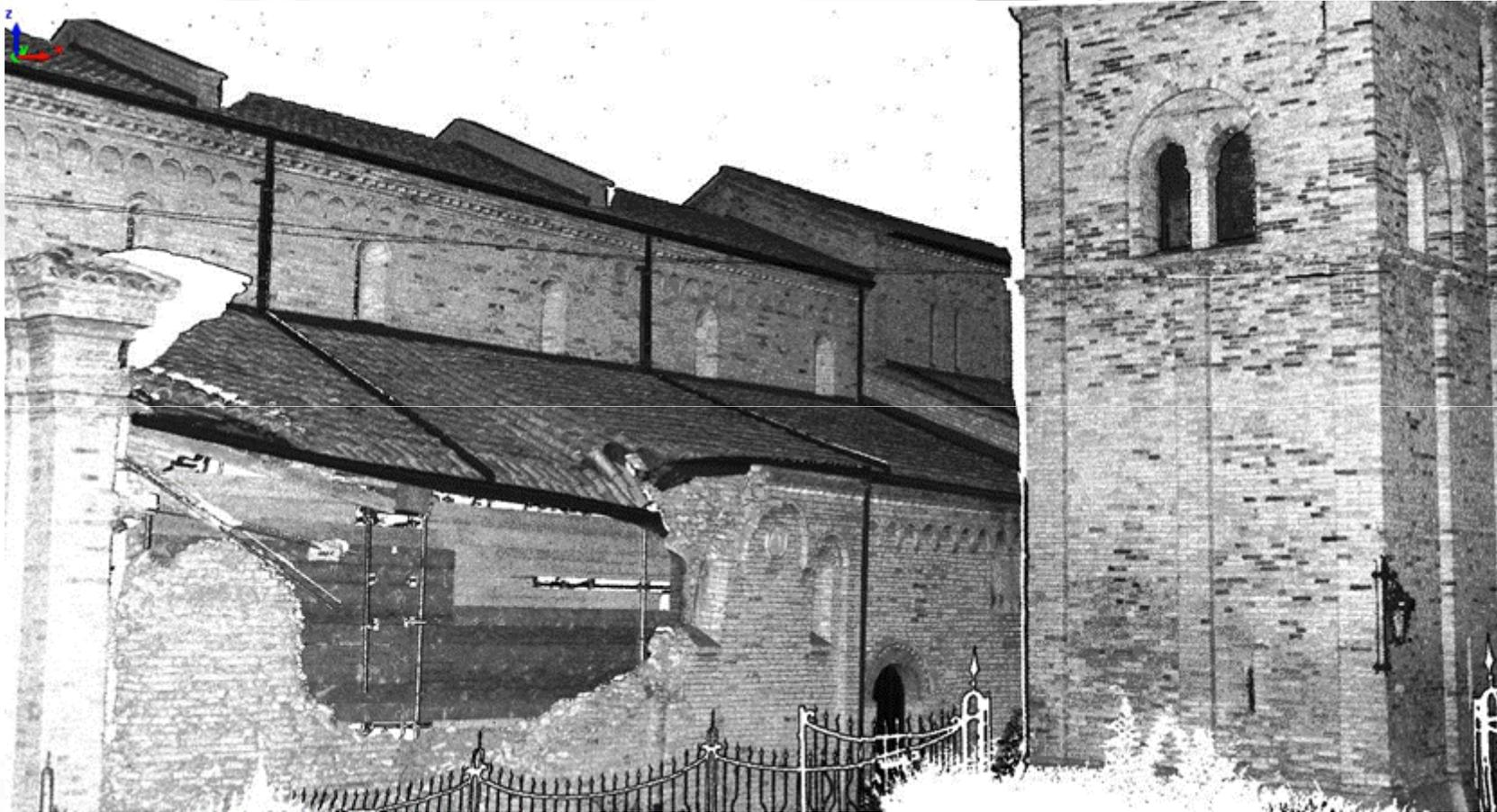
I risultati mostrano, in particolare, una deformazione nella parte alta del campanile presumibilmente dovuta all'interazione tra la struttura della cella campanaria e l'apparecchio murario, la rottura dei conci di chiave e una sorta di rotazione dell'ultima sezione rispetto alla parte sottostante.
