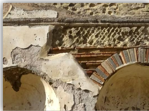
Ortofoto ad alta risoluzione (1 pixel = 6mm) della facciata, con resa ottimale delle geometrie sia sul piano principale che negli spazi più profondi occupati dalle nicchie.
