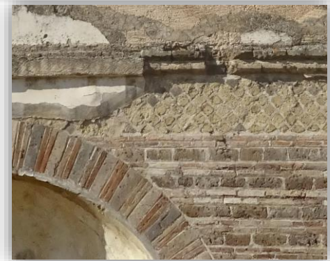
Ortofoto ad alta risoluzione (1 pixel = 6mm) della facciata, con resa ottimale delle geometrie sia sul piano principale che negli spazi più profondi occupati dalle nicchie.
